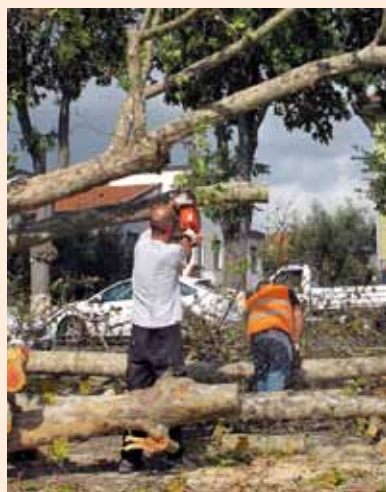
Gli operai del Comune a lavoro per liberare la strada dalla caduta di un albero (Foto AFF)
