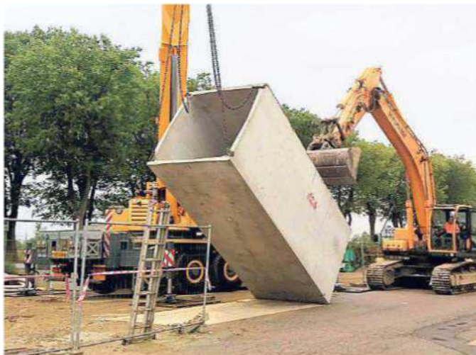
Il cantiere del nuovo sistema fognario
