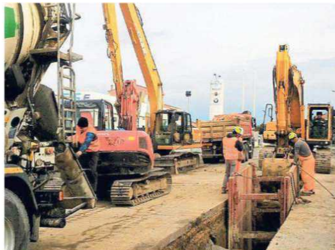
Operai al lavoro per costruire la fognatura
