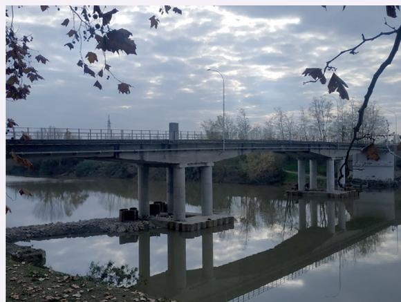
dalle palificate realizzate sia sul terreno in prossimità delle spalle che in acqua per le pile, si è ottenuto un ampliamento delle sezioni esistenti e un **complessivo miglioramento sismico delle sottostrutture del ponte**.
