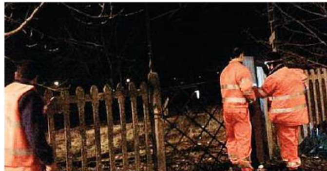
Operatori intenti a chiudere il varco d'accesso ai binari
