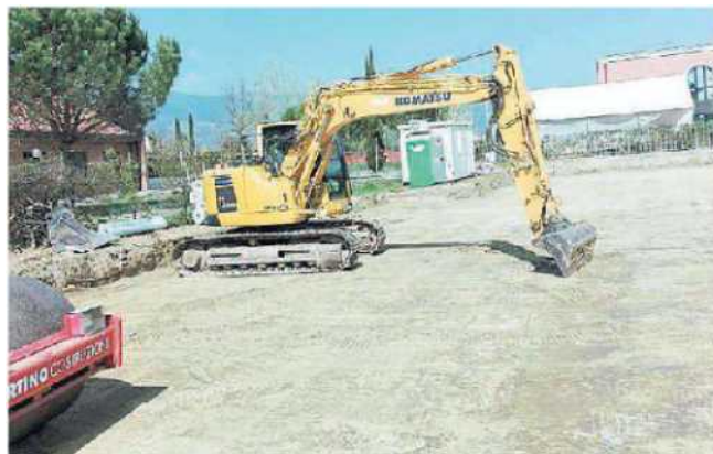
Il cantiere a Fornacette
