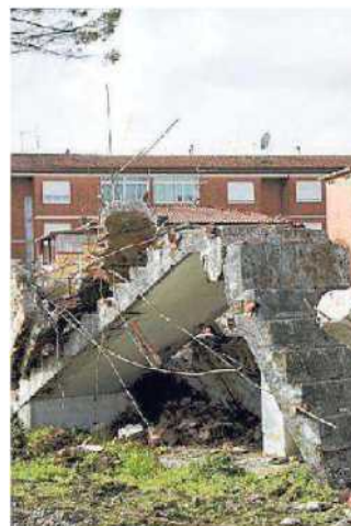
La demolizione dell'ex velodromo
