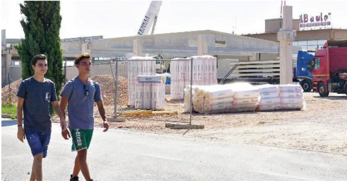
Il cantiere dell'Eurospin sorge nell'area industriale fra Le Melorie e il centro di Ponsacco, a fianco alla Lidl
