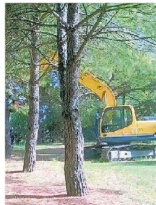
I lavori a Fornacette
