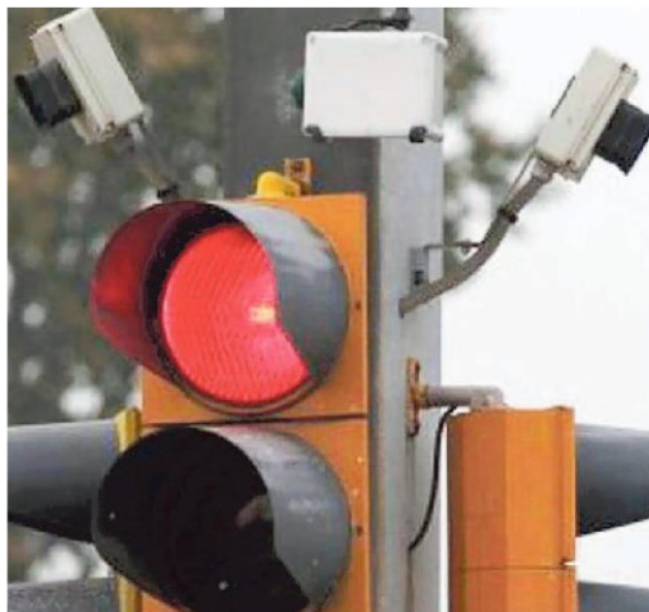
Il semaforo dotato di telecamere
