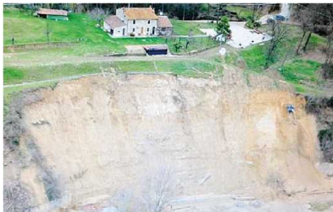
L'impressionante frana del Ponte alla Navetta
