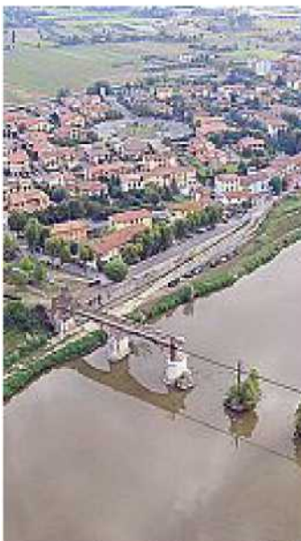
Il ponte ferroviario bombardato e mai più ricostruito
