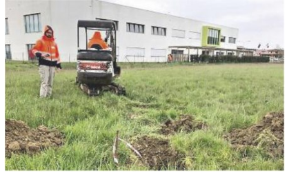
I lavori preliminari del cantiere con l'installazione della recinzione. Poi a marzo inizierà la costruzione
