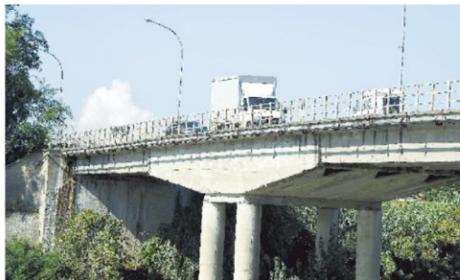
Il ponte in via Papa Giovanni XXIII a Calcinaia
