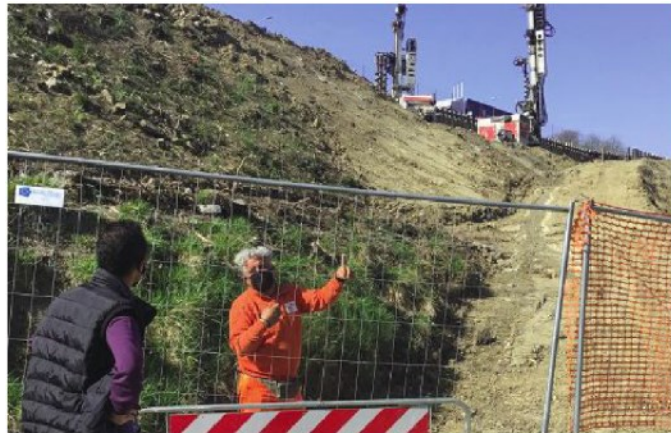
Il cantiere in via di Carcheri a Lastra a Signa
