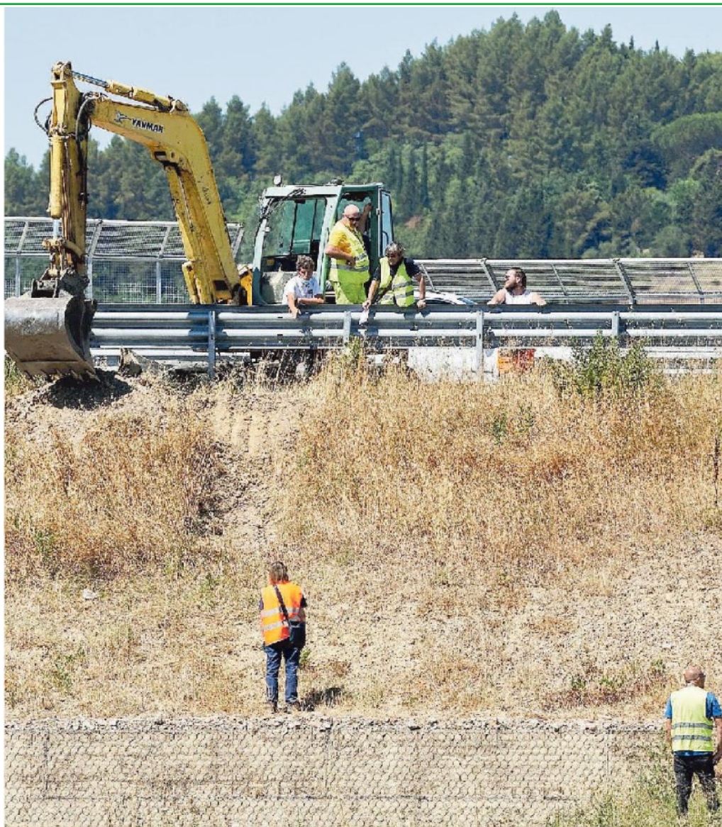
Controlli nei terreni per verificare la presenza di Keu nell'Empolese
