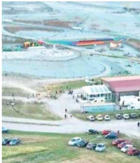
Un'area della discarica di Legoli dove sorgerà l'impianto di ossicombustione, al centro del confronto tra sindaci dei Comuni “Rifiuti zero”
