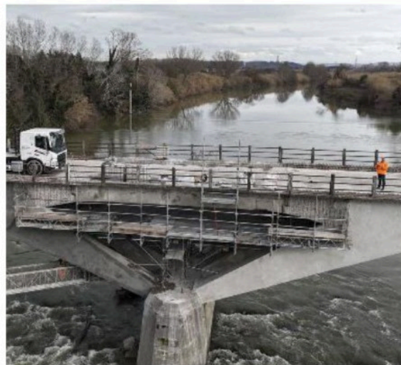
I lavori al Ponte alla Botte
