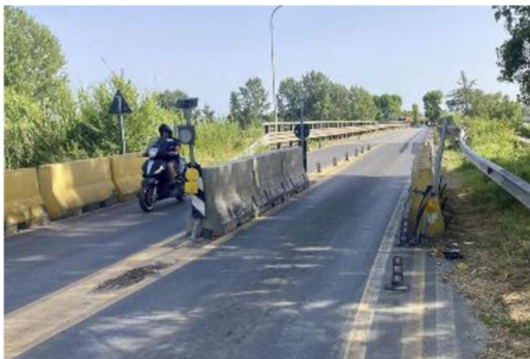
Il Ponte alla Botte chiuso per lavori alla struttura
