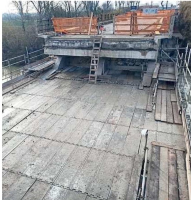
I lavori al Ponte della Botte che stanno causando forti disagi alla popolazione
